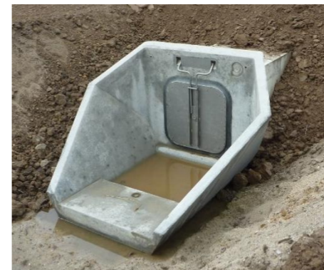
Kopfstück mit rechteckiger Rückstauklappe
