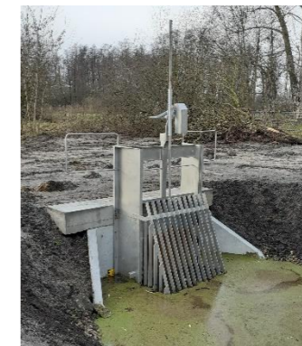
Kopfstück mit Stauvorsatz, Rechen, Gesimsbalken, Absturzicherung
