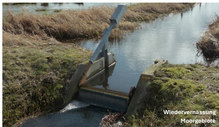
Stauanlage im Regelbetrieb
